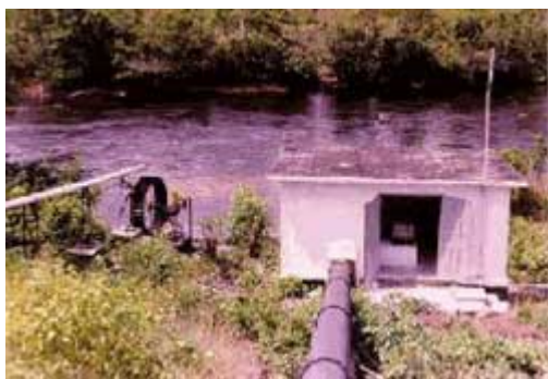
Usina hidrelétrica de 37,5 kva, construída no rio Braço Norte, próximo à cachoeira.
